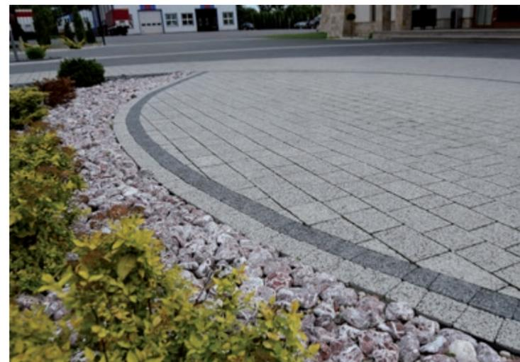
Продукция производится с использованием технологии облагораживания в рамках соответствующего процесса полоскания верхнего слоя только что сформированных изделий. Частицы бетона верхнего слоя смываются, благодаря чему наверх выходит более крупное декоративное зерно с интенсивным цветом.
