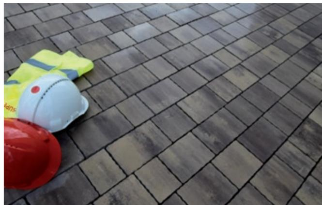
При укладке следует помнить об общих правилах укладки плитки данной серии, то есть технологии смешивания отдельных слоев из разных палет, и других условиях, связанных с характеристиками данной формы и требованиями к использованию поверхности.
