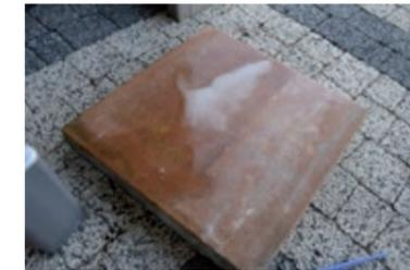
Удаление разводов средством. На действие средства указывает образование пены на поверхности и выделение тепла.
